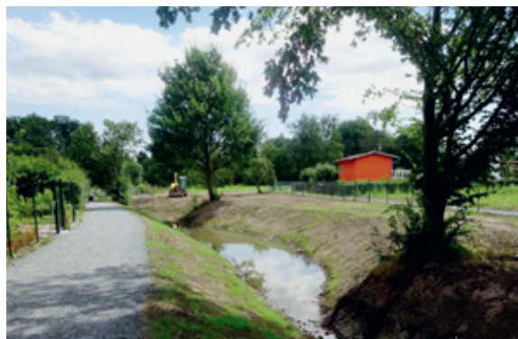
Nach Rückbau – Öffnung für Fußgänger
