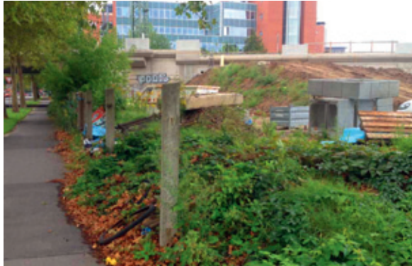
Baustellenfläche der Deutschen Bahn
