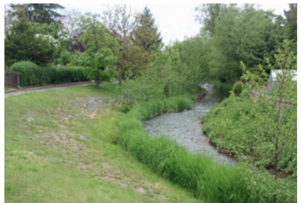
Naturnah umgebauter Gewässerrandstreifen
