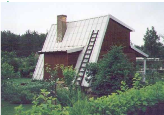
• Besonders umweltfreundlich geht es hier in Polen zu, • wo ein kleines Haus ganz nach den Regeln eines sogenannten Passivhauses erstellt wurde.
