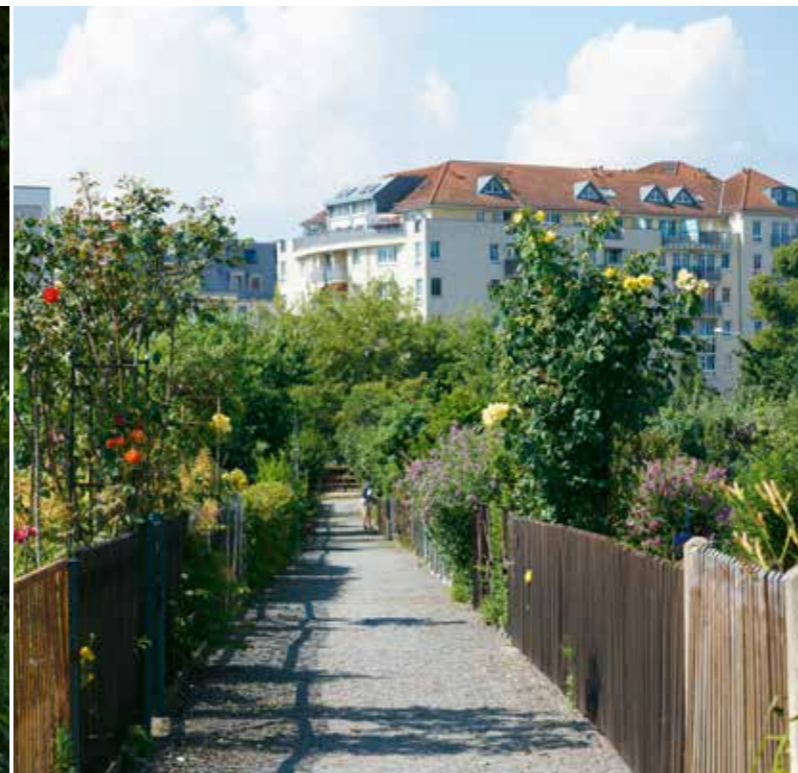
Wohnbebauung neben der Anlage Flora I, Dresden
