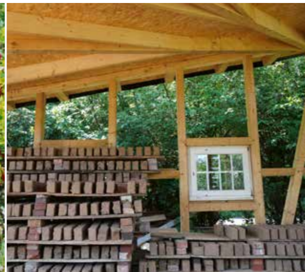
Laube mit Lehmziegeln im Schulgarten Bremen
